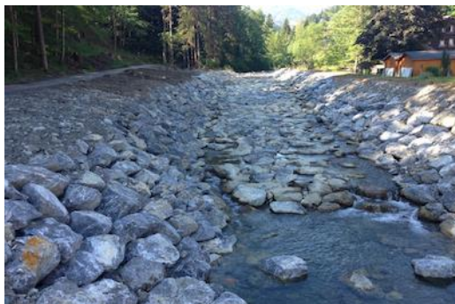
Figure 109 : Rampe en enrochements jointifs (Petite Simme à Zweisimmen).
