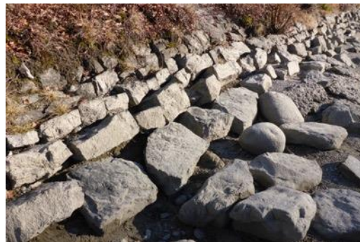
Figure 50 : Perré dégradé par glissement ; les rangées de blocs sont encore visibles (Aar à Berne).
