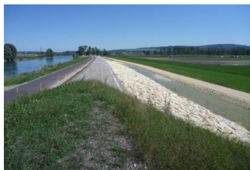
Figure 6 : Digue submersible (tronçon submersible d'une digue de protection contre les crues ; Aar à Walperswil).
