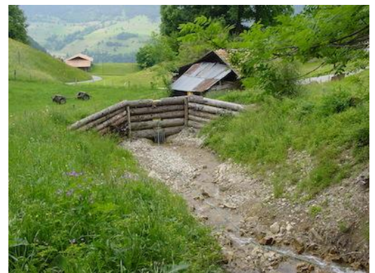
Figure 155 : Ouvrage de rétention des matériaux charriés, dépotoir à alluvions (Schwandmattigraben).
