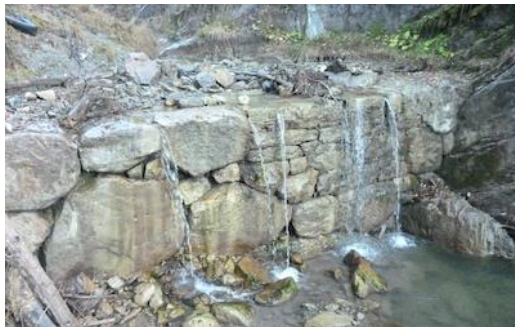
Figure 135 : Barrage en moellons (Traubach à Habkern).
