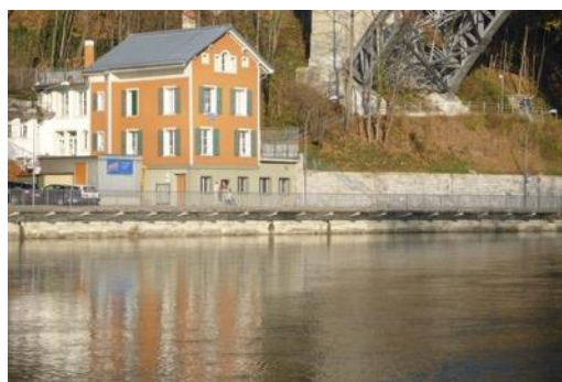
Figure 68 : Mur de soutènement en béton (Aar à Berne).
