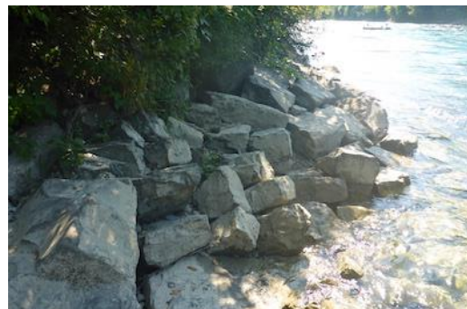
Figure 51 : Enrochement irrégulier (Aar à Steffisburg).
