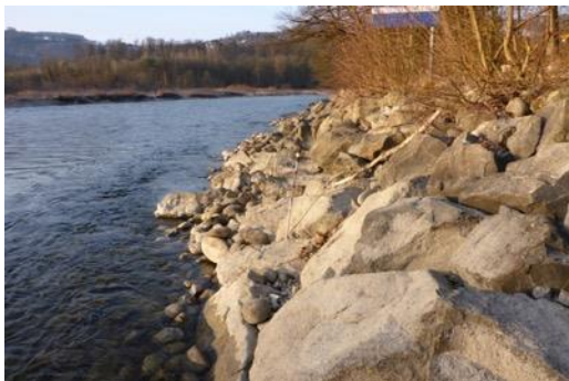
Figure 49 : Enrochement régulier (Aar à Muri, Berne).
