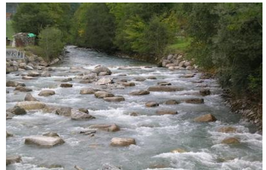
Figure 110 : Rampe en enrochements disjoints structurée (Simme à St. Stephan).
