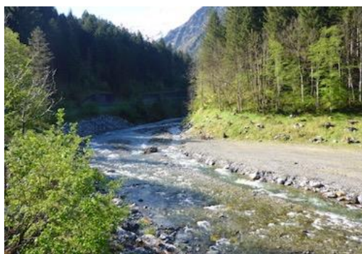
Figure 188 : Tronçon dosant vu en direction de l'amont (Haasliaare à Innertkirchen).
