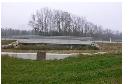
Figure 90 : Ouvrage de sortie d'une surface inondable (Ancien Aar à Dotzigen).
