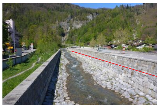
Figure 83 : Mur de protection en enrochement (Alpbach à Märtpplatz).
