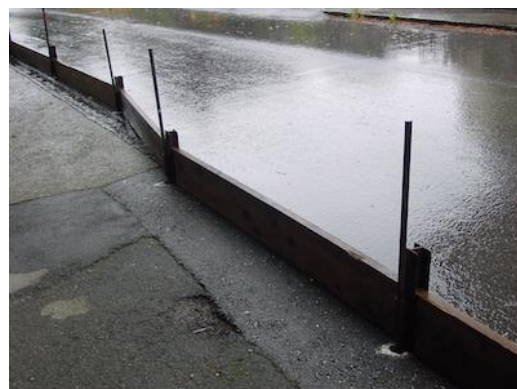
Figure 31 : Mesure mobile, lattes de bois avec rails de guidage (Leusegraben à Wichtrach).
