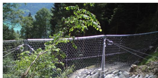
Figure 159 : Filet de retenue pour les laves torrentielles Geobrugg UX, UX-160-H4 (Trachtbach à Brienz).
