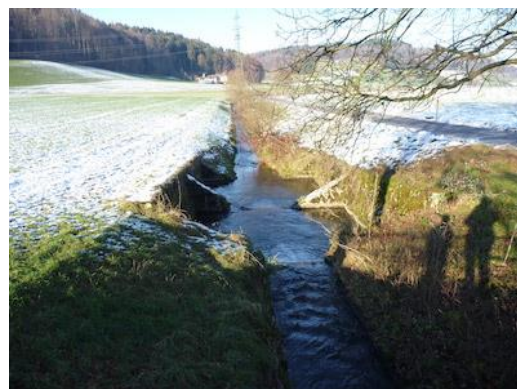
Figure 189 : Ouvrage de rétention des matériaux charriés, dépotoir à alluvions (Önz à Wynigen).
