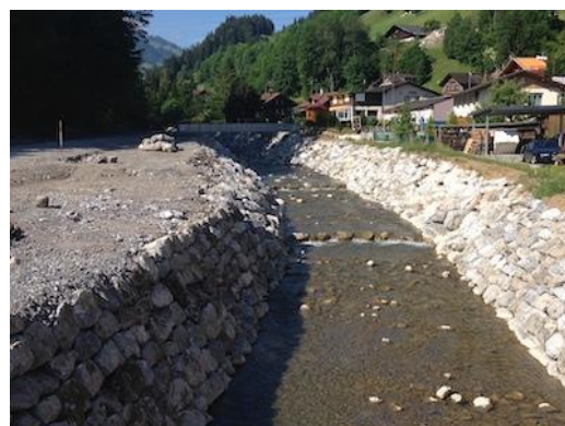
Figure 141 : Barre d'enrochement (Petite Simme à Zweisimmen).
