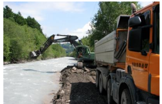
Figure 185 : Apport de gravier destiné à stabiliser le lit sur un site de déversement de matériaux charriés (Kander à Rechenbach).
