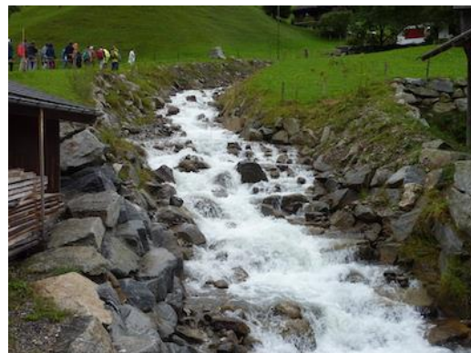
Figure 115 : Lit en enrochement (Diesselbach dans le Melchtal).
