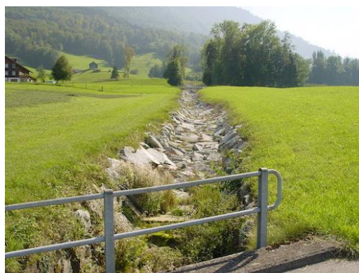
Figure 119 : Lit en enrochement (Rübibach à Buochs).
