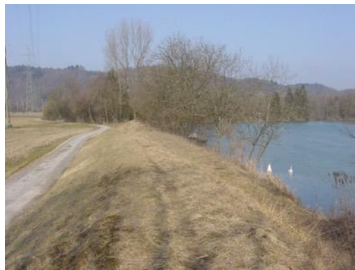
Figure 4 : Digue non submersible, déjà ancienne (Aar près de l'embouchure de la Sarine).
