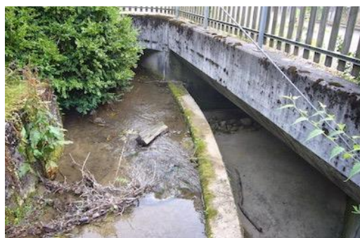
Figure 95 : Prise d'eau d'un canal de décharge (ruisseau de Mettembert à Soyhières).
