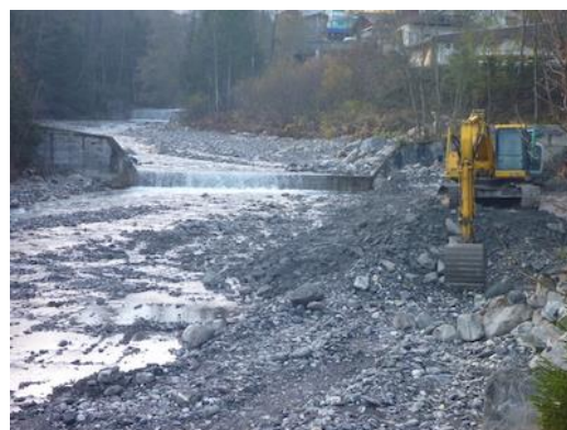
Figure 190 : Zone de gestion de dépôt d'alluvions (Engstlige à Adelsboden).
