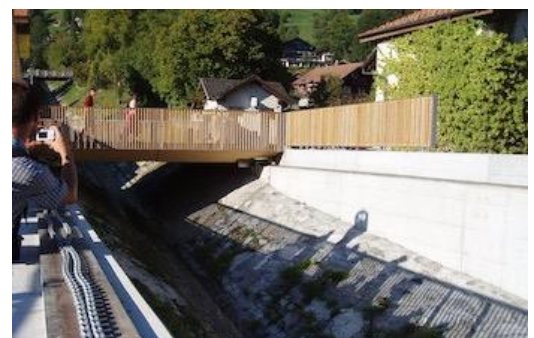
Figure 44 : Pont mobile coulissant vers l'aval (Trachtbach à Brienz).
