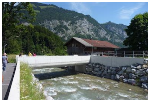
Figure 36 : Carénage de pont (Chirel à Diemtigen).
