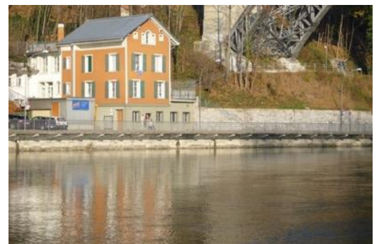
Figure 56 : Mur de soutènement en béton (Aar à Berne).
