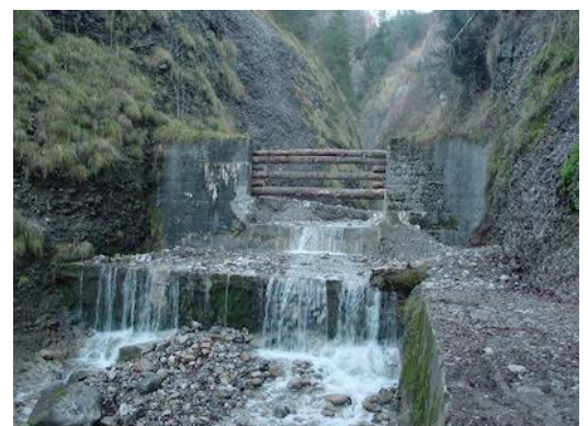
Figure 156 : Ouvrage de rétention des matériaux charriés, barrage-grille à poutres horizontales (Guntenschbach).
