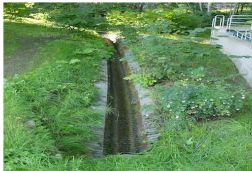
Figure 13 : Cunette en métal (Mühlebach à Beckenried).
