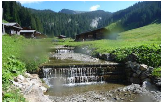
Figure 136 : Caisson en bois (Traubach à Habkern).
