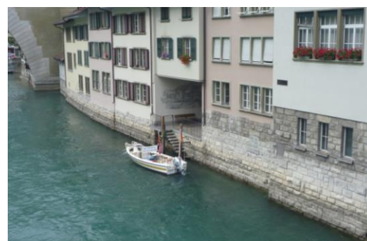
Figure 27 : Mur avec fonction de soutènement (Aar dans le quartier de la Matte en amont du pont de Nydegg.)
