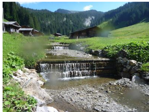
Figure 140 : Caisson en bois (Traubach à Habkern).
