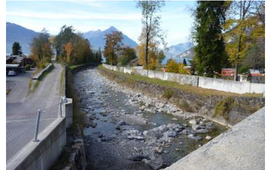
Figure 21 : Mur de protection en béton (Lombach à Unterseen).
