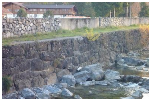
Figure 72 : Mur de soutènement en enrochement (Lombach à Unterseen).
