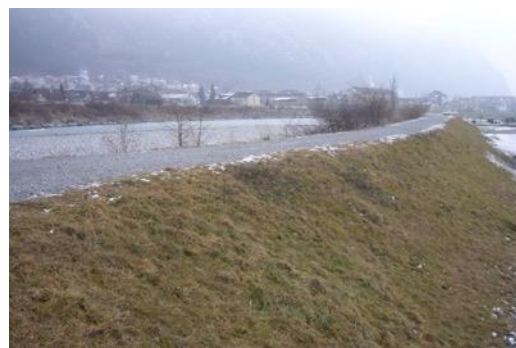
Figure 5 : Digue non submersible (son côté exposé à l'air n'est recouvert que d'herbe, la surface ne présente pas de couverture résistante à la submersion ; Reuss à Erstfeld).
