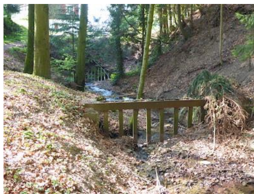
Figure 167 : Ouvrage de rétention de bois flottant, grille verticale (Dorfbach à Merlischachen).
