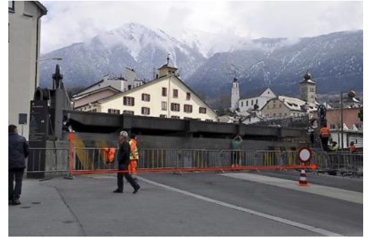
Figure 46 : Pont en position relevée sur la Saltina à Brig-Glis. Le pont élève avec lui une plaque mobile en acier qui empêche que de l'eau s'échappe par-dessous le pont.
