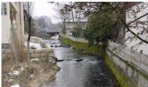
Figure 30 : Paroi en bois (à droite) destinée à protéger de l'inondation (Lyssbach à Lyss).
