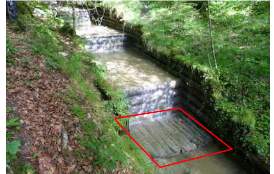
Figure 124 : Platelage (Bie / ruisseau de Châtillon à Châtillon JU).
