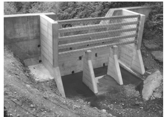
Figure 170 : Ouvrage de rétention des matériaux charriés et de bois flottant, cloison siphonide (Bitzighoferbach ; source : VAW Mitteilung 188, 2006).
