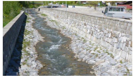
Figure 121 : Pavage du lit (Alpbach à Märtplatz).
