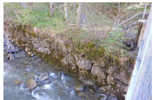
Figure 25 : Mur de soutènement en enrochement (Lombach à Unterseen).
