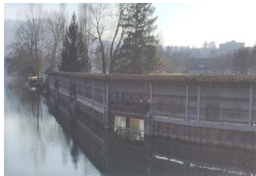
Figure 77 : Rideau de palplanches protégeant la rive contre l'érosion. Il est composé de divers profils spécifiques (Marzili, Berne).
