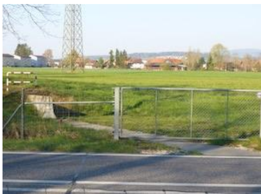
Figure 34 : Mesure mobile, système d'éléments en béton ; en cas d'événement extrême, des éléments en béton sont mis en place (ancien Aar à Studen).
