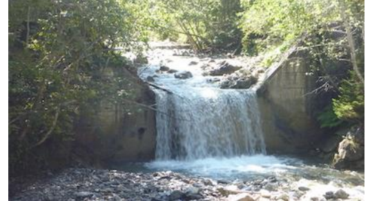
Figure 137 : Barrage en béton (Gilsbach à Adelboden).
