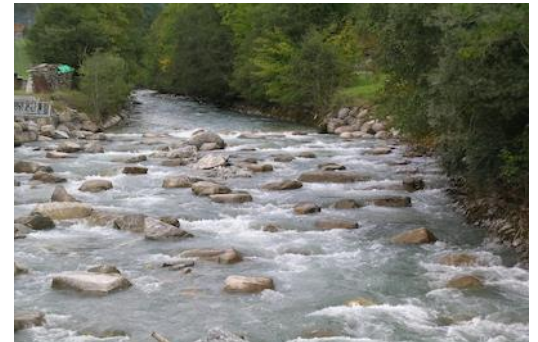
Figure 130 : Rampe en enrochements disjoints structurée (Simme à St. Stephan).
