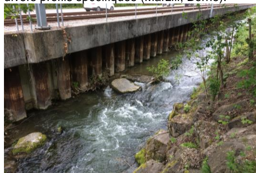
Figure 77 : Rideau de palplanches protégeant la rive contre l'érosion. Il est composé de divers profils spécifiques (Marzili, Berne).
