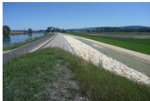
Figure 91 : Tronçon submersible d'une digue de protection contre les crues (Aar à Walperswil).
