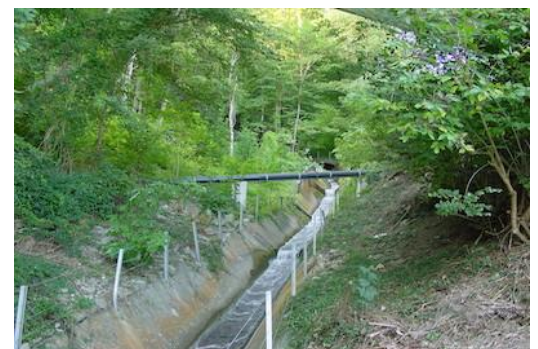
Figure 131 : Cunette (Mocklisbach à Beckenried).
