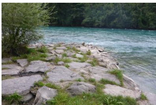
Figure 59 : Tortue, blocs non travaillés pris dans du béton de structure (Aar à Rubigen).
