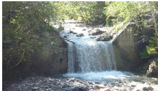
Figure 134 : Barrage en béton (Gilsbach à Adalboden).
