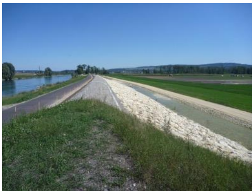
Figure 3 : Tronçon submersible d'une digue (Aar à Walperswil).
