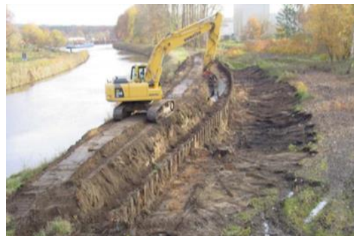
Figure 7 : Rideau de palplanches submersible (source : TB Hochwasserschutz Hasliaare, Herzog, 2013).
