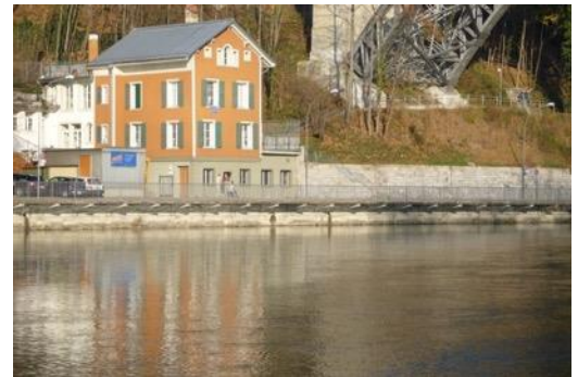
Figure 24 : Mur de soutènement en béton (Aar à Berne).
