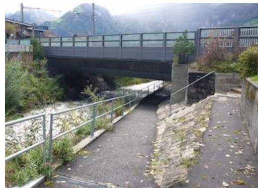
Figure 37 : Carénage sous la face inférieure du pont (Riemenstaldnerbach à Sissikon).
