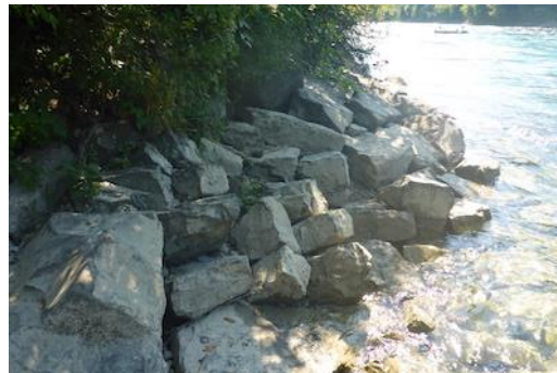
Figure 48 : Enrochement irrégulier (Aar à Steffisburg).
