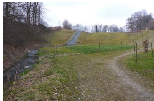
Figure 174 : Bassin de rétention des crues (Tägertschibach à Münsingen).
