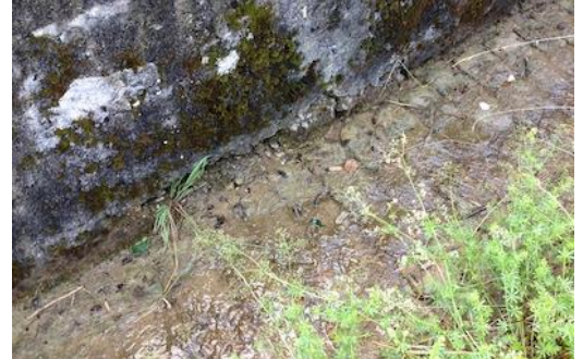
Figure 120 : Pavage du lit (Chratzbach à Thoune).
