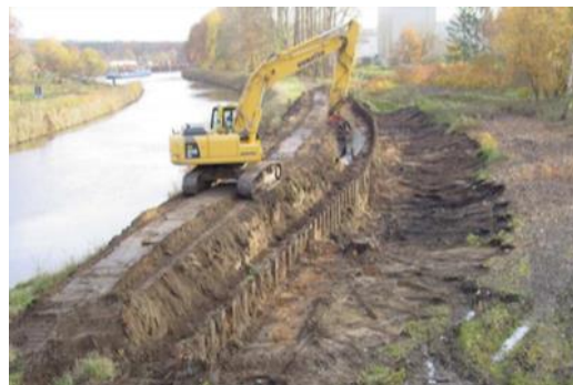
Figure 84 : Rideau de palplanches submersible (source : TB Hochwasserschutz Hasliaare, Herzog, 2013).
