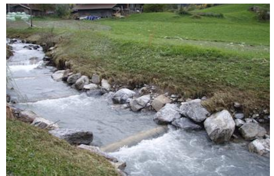
Figure 16 : Système de traverses (Stegbach à Mitholz).
