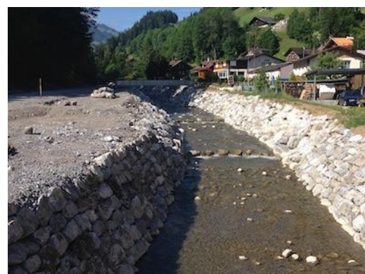
Figure 113 : Barre d'enrochement (Petite Simme à Zweisimmen).
