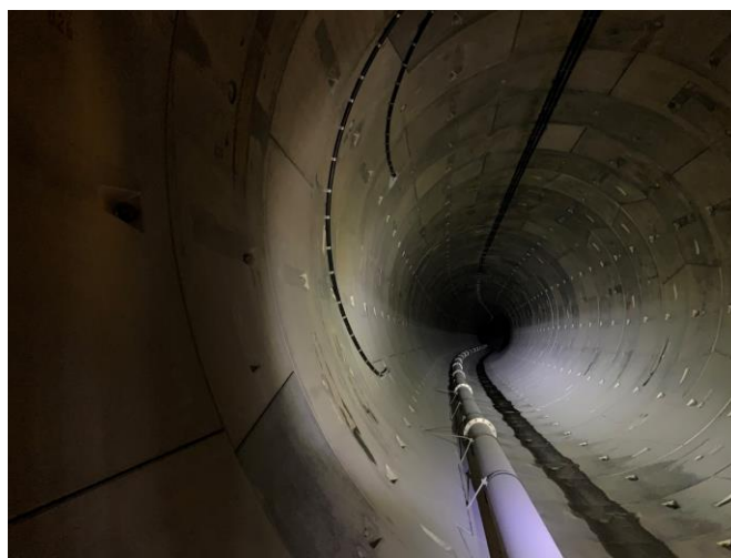
Figure 93 : Galerie d'évacuation des crues, Aar, Thoune (OPC 2021).
