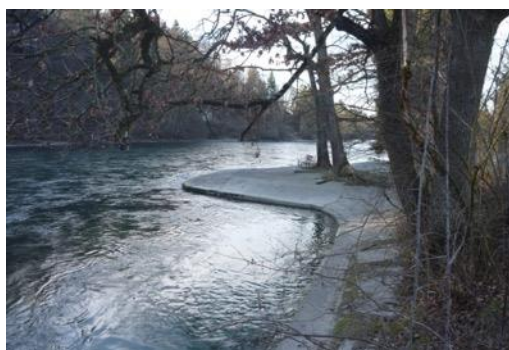
Figure 58 : Épi en béton avec ouvrage longitudinal / revêtement de berge sur son côté amont (Aar à Münsingen).
