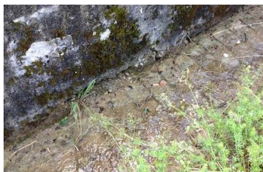
Figure 117 : Pavage du lit (Chratzbach à Thun).
