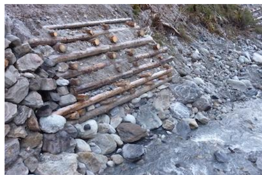
Figure 74 : Caisson en bois, longrines pour la protection contre l'érosion latérale ; les couches inférieures sont remplies (Schwarze Lutschine, Grindelwald).
