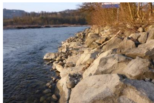
Figure 52 : Enrochement régulier (Aar à Muri, Berne).
