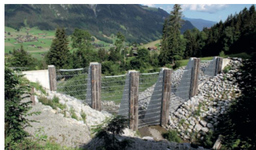
Figure 157 : Filet de retenue pour les laves torrentielles (système indéfini) : ouvrage de rétention des matériaux charriés formé d'un filet avec piliers en béton (Innere Sitebach à Lenk i.S. ; source : WSL Heft 102, 2020).
