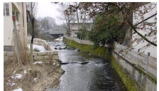
Figure 23 : Mur de protection en encrochement (à gauche), mur de soutènement en béton recouvert par la végétation (à droite) et paroi en bois (à droite) (Lyssbach à Lyss).
