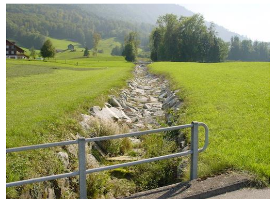
Figure 125 : Lit en enrochement (Rübibach à Buochs).
