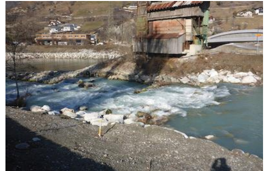
Figure 129 : Rampe en enrochements jointifs posés (Viège à Viège).
