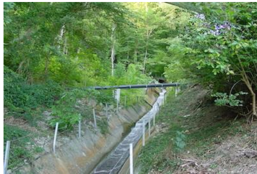
Figure 11 : Cunette (Mocklisbach à Beckenried).
