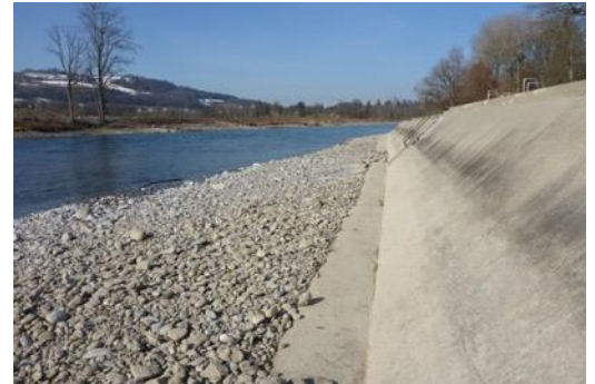
Figure 54 : Plaques de béton (Aar à Muri, Berne).
