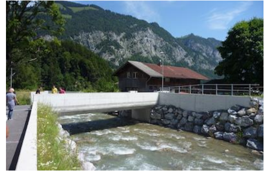
Figure 38 : Carénage sous la forme d'un pont à pression (Chirel à Diemtigen).
