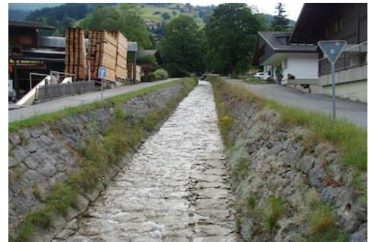
Figure 14 : Cunette de torrent constituée d'enrochements bruts de forme variable (Innere Sitebach à Lenk).
