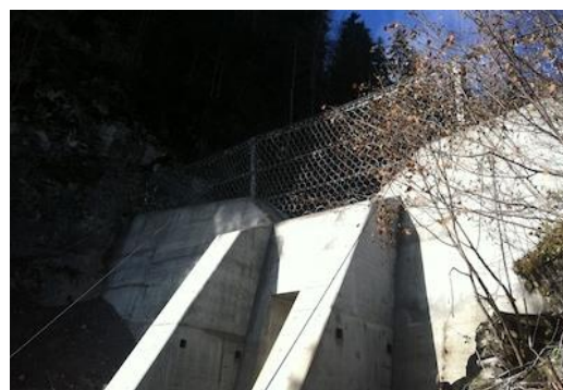
Figure 158 : Ouvrage de rétention des matériaux charriés avec filet de retenue pour les laves torrentielles ; le filet de retenue est > 5 m et doit donc être saisi en tant qu'objet distinct (Gryfenbach à Lauterbrunnen).
