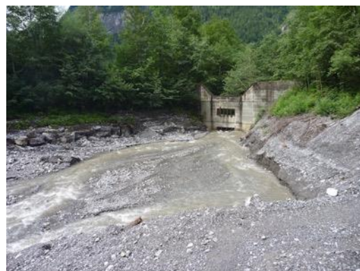
Figure 142 : Ouvrage de rétention des matériaux charriés prenant la forme d'un dépotoir à alluvions (Stegenbach à Kandergrund).
