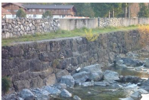
Figure 69 : Mur de soutènement en enrochement (Lombach à Unterseen ; mur inférieur le long du chenal).
