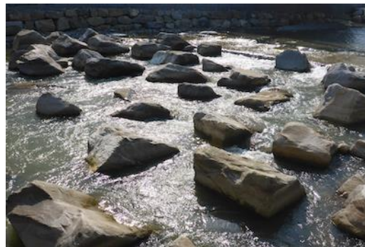
Figure 108 : Rampe en enrochements disjoints (Petite Emme à Emmenbrücke).
