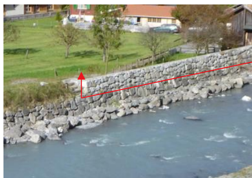
Figure 18 : Nouveau mur de protection en enrochement (blocs pris dans du béton de structure) (Lütschine à Gsteig).
