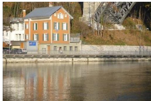
Figure 71 : Mur de soutènement en béton (Aar à Berne).
