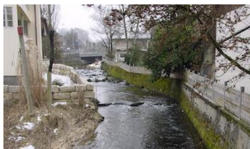
Figure 20 : Mur de protection en enrochement (à gauche), mur de soutènement en béton recouvert par la végétation (à droite) et paroi en bois (à droite) (Lyssbach à Lyss).
