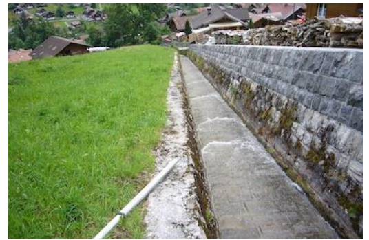
Figure 15 : Cunette de torrent constituée d'enrochements taillés / fendus (Gryfenbach à Lauterbrunnen).
