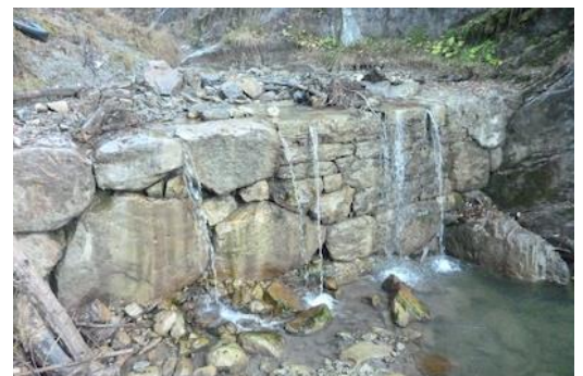
Figure 139 : Barrage en moellons (Traubach à Habkern).
