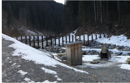
Figure 169 : Ouvrage de rétention de bois flottant, grille en V (Petite Simme).
