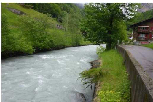
Figure 19 : Ancien mur de protection en béton (Weisse Lütschine à Lauterbrunnen).
