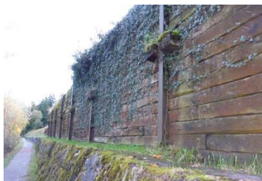
Figure 29 : Paroi en bois (Lombach à Unterseen).
