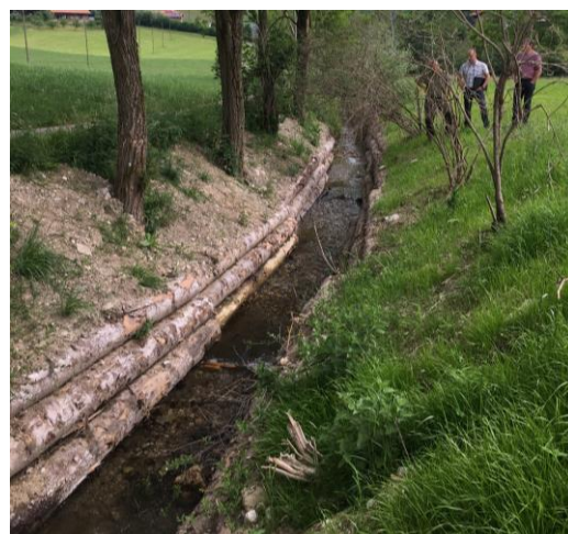
Figure 75 : Longrines permettant d'éviter l'érosion latérale (Walkringen. OPC 2017).
