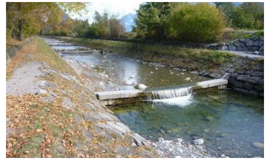
Figure 138 : Seuil en béton (Lombach à Unterseen).
