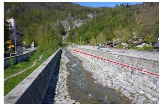
Figure 22 : Mur de protection en encrochement, en dessus de la ligne rouge (Alpbach à Märtplatz).
