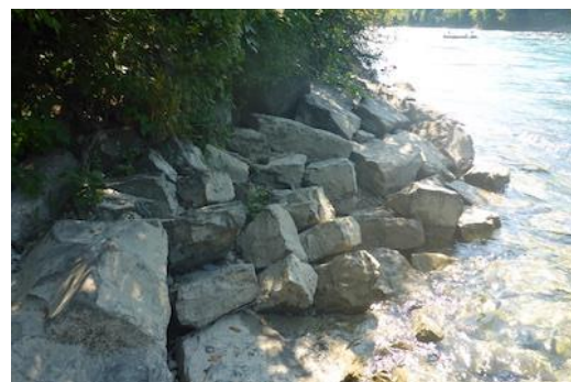
Figure 85 : Enrochement irrégulier (Aar à Steffisburg).
