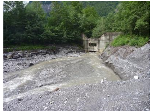
Figure 147 : Ouvrage de rétention des matériaux charriés prenant la forme d'un dépotoir à alluvions (Stegenbach à Kandergrund).
