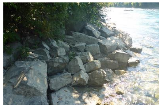
Figure 114 : Enrochement irrégulier (Aar à Steffisburg).
