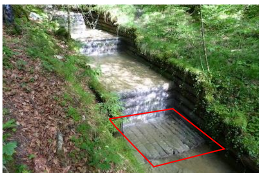
Figure 118 : Platelage (Bie / ruisseau de Châtillon à Châtillon JU).
