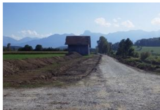
Figure 8 : Dépôt de terre en forme de digue à proximité du chenal (à gauche sur la photo, entre la route et le champ ; Gürbe à Mühlethurnen).
