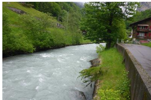
Figure 82 : Vieux mur de protection en béton (Weisse Lütschine à Lauterbrunnen).
