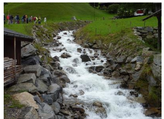
Figure 126 : Lit en enrochement (Diesselbach dans le Melchtal).
