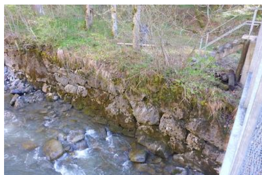
Figure 73 : Mur de soutènement en enrochement (Lombach à Unterseen).
