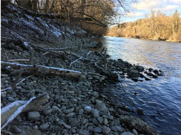
Abbildung 10: Zerstörter Längsverbau, Aare Belp (TAB, 2018)
