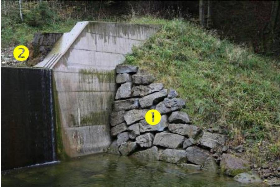
Abbildung 6: Sicherung der Sperre durch kurzen Längsverbau bzw. Stützmauer (SBK LU vif/NG 2018)
