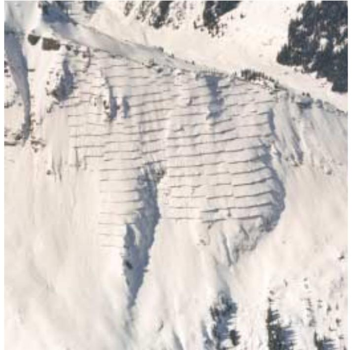
In keiner einzigen Lawinenverbauung im Berner Oberland sind Lawinen angerissen, die bedeutende Schäden an der Verbauung oder an darunterliegendem Schadenpotenzial verursacht haben. Das System des Stützverbaus hat sich somit auch in der Extremsituation ausnahmslos sehr gut bewährt.
