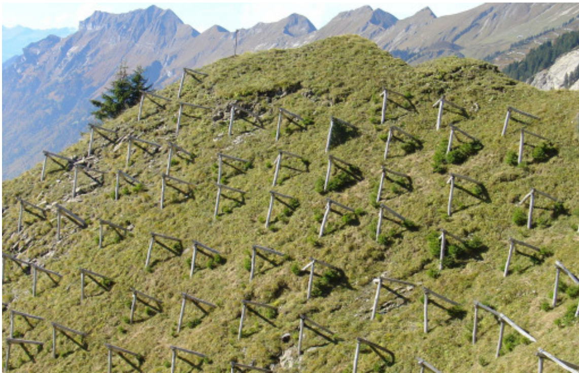
Abb 35 Gleitschneeverbau mit Dreibeinböcken
