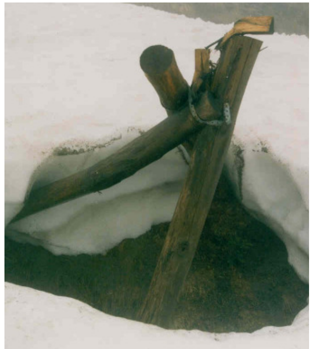
Abb 37 Extremes Schneegleiten kann auch an Dreibeinböcken Schäden verursachen
