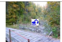
(e) Brücke Stockweg, frei von Schwemmholtz halten. ACHTUNG: Brücke mit geringer Nutzlast
