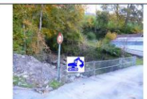
(c) Brücke Allniveg, frei von Schwemmholtz halten
